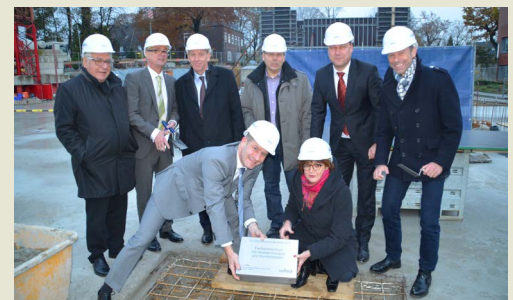
DER GRUNDSTEIN WIRD VON THOMAS TATKA (GF KK BOTTROP) UND BETTINA AM ORDE (AUFSICHTSRATSVORSITZENDE) AUF DER BAUSTELLE PLATZIERT.
