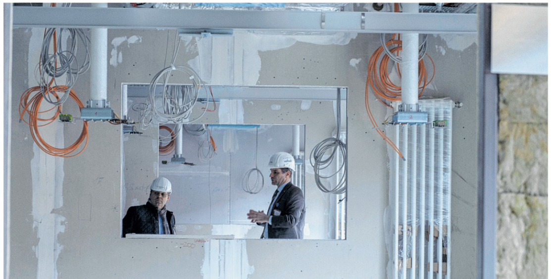
Durchbrüche in den Wänden lassen die Intensivstation erkennen. Thomas Tatka (re.) und Volker Fichna überprüfen stets den Fortschritt der Arbeiten. FOTOS: OLAF FUHRMANN
