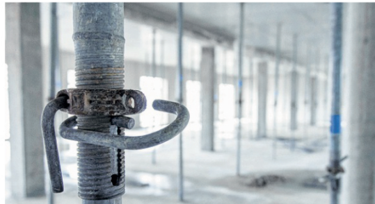
Die Etage für die Arztpraxen zeigt sich – unterbrochen von unzähligen Stützen – in voller Weite. Die endgültige Raumplanung erfolgt erst, wenn alles vermietet ist.
