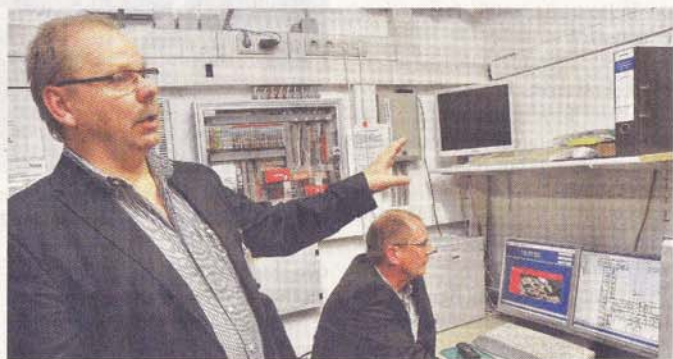
Von der Kommunikationszentrale aus können Brandmeldeanlage, Aufzüge, Schranken und Türen überwacht werden.
