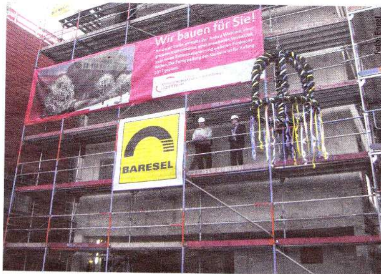
In einem Jahr soll der Anbau fertig sein.
