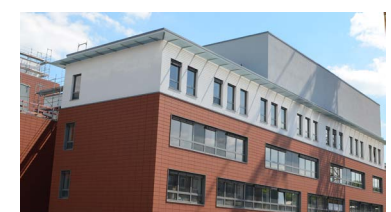
DER NEUE ANBAU WEST WURDE IM SEPTEMBER OFFIZIELL EWINGEWIEHT, DIE INBETRIEBNAHME ERFOLGT STÜCK FÜR STÜCK IN DER KOMMENDEN ZEIT.
